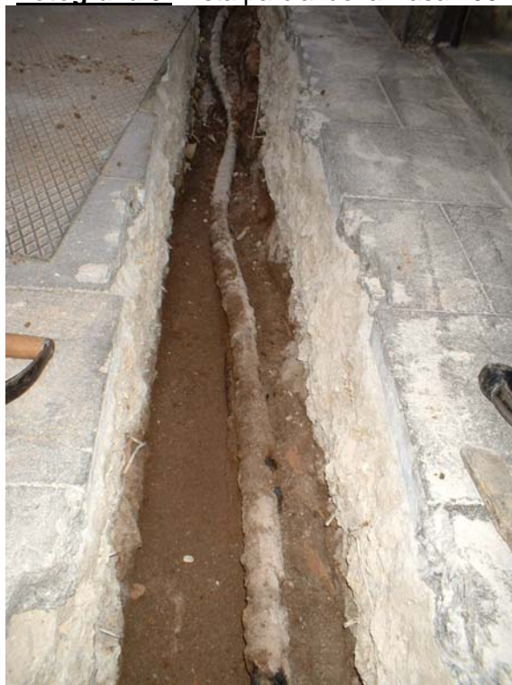
Fotografia 4: Vista d'un servei elèctric anterior que es va trobar a 60 cm de profunditat durant les tasques d'obertura de la rasa.
