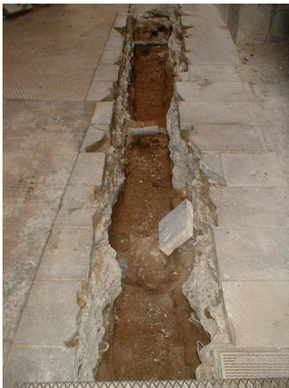
Fotografia 3: Vista parcial de la Rasa 100.
